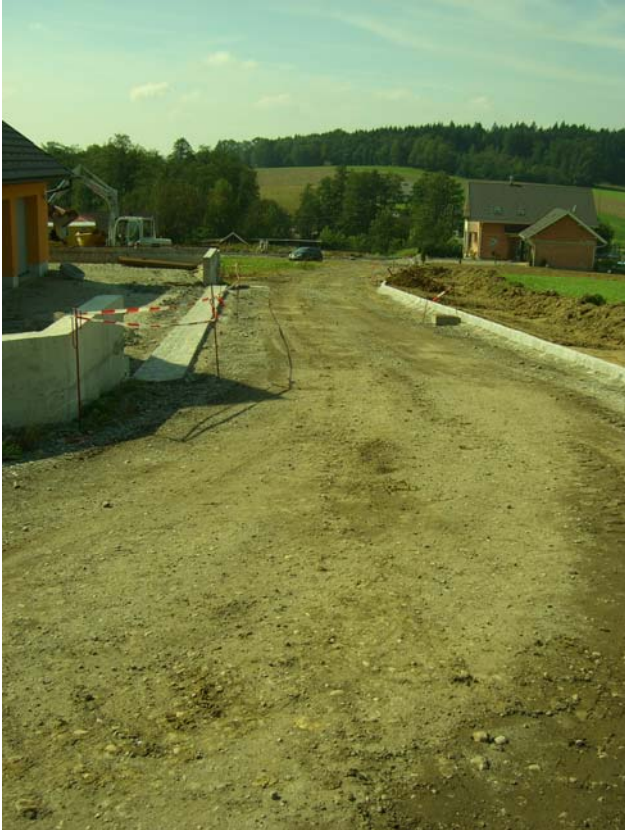
Gemeindestraße Mitterweg, Staubfreimachung und Herstellung der Nebenanlagen
