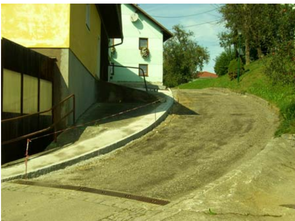
Zufahrt Leithen (Sanierung und Staubfreimachung)
