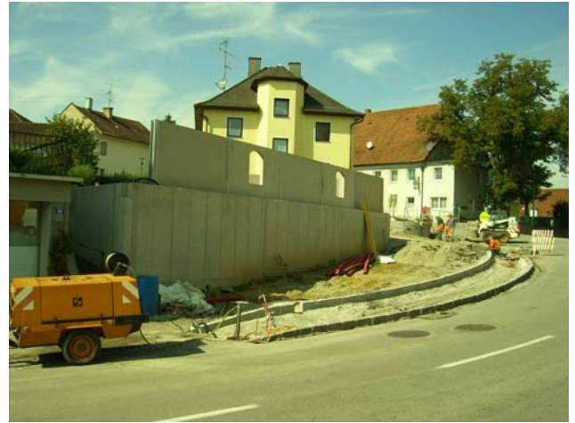
B 129 Eferdinger Straße, Gehsteigverbreiterung im Bereich der Liegenschaft Wölfleder
