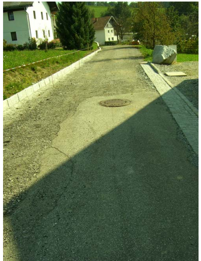
Staubfreimachung und Herstellung der Nebenanlagen im Bereich der Zufahrt Grub (Kieslinger)
